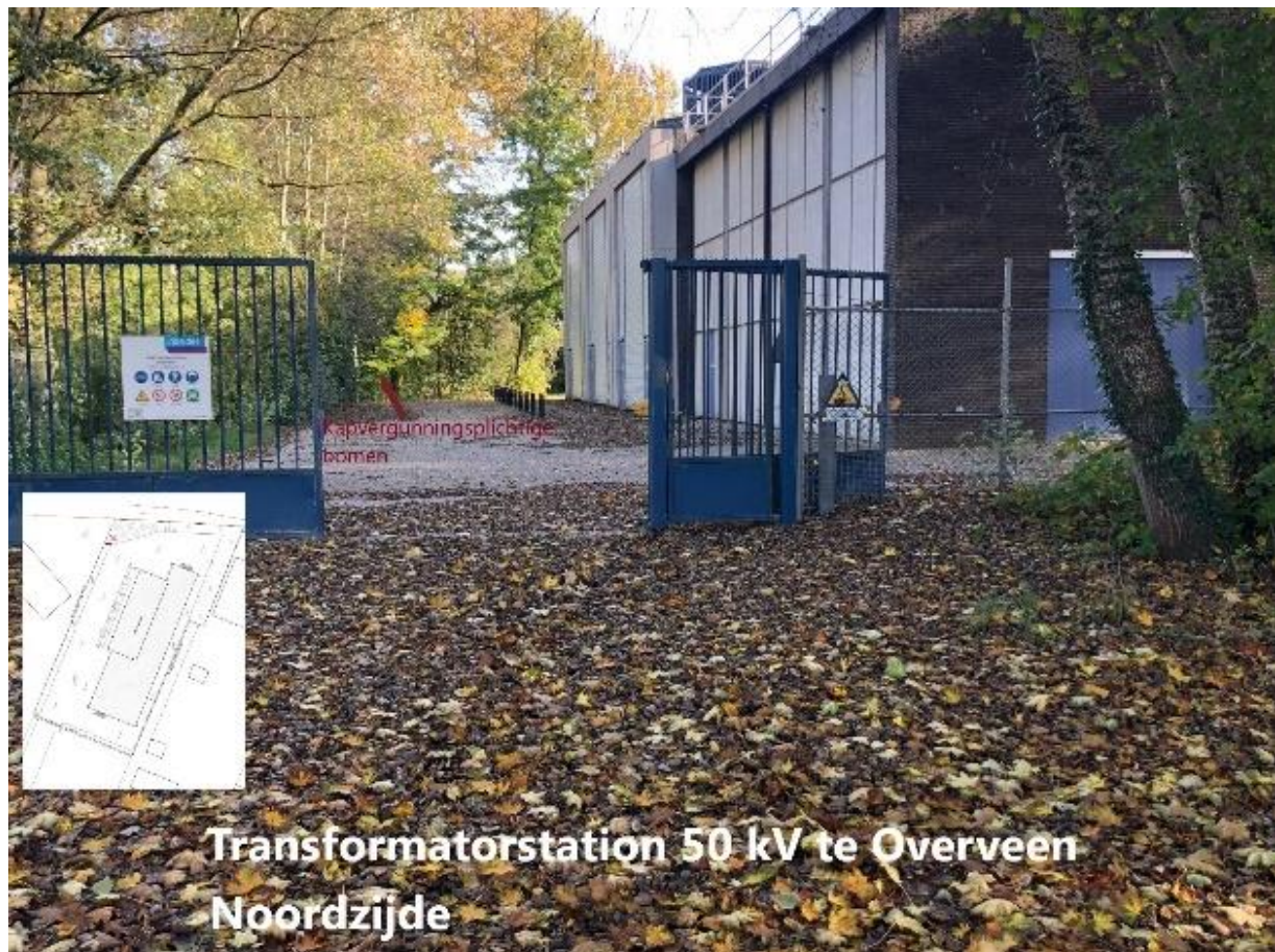
1. Transformatorstation (50 kV-station) Overveen. Voorkant aan noordzijde. De betwiste bomen helemaal links achterin.
