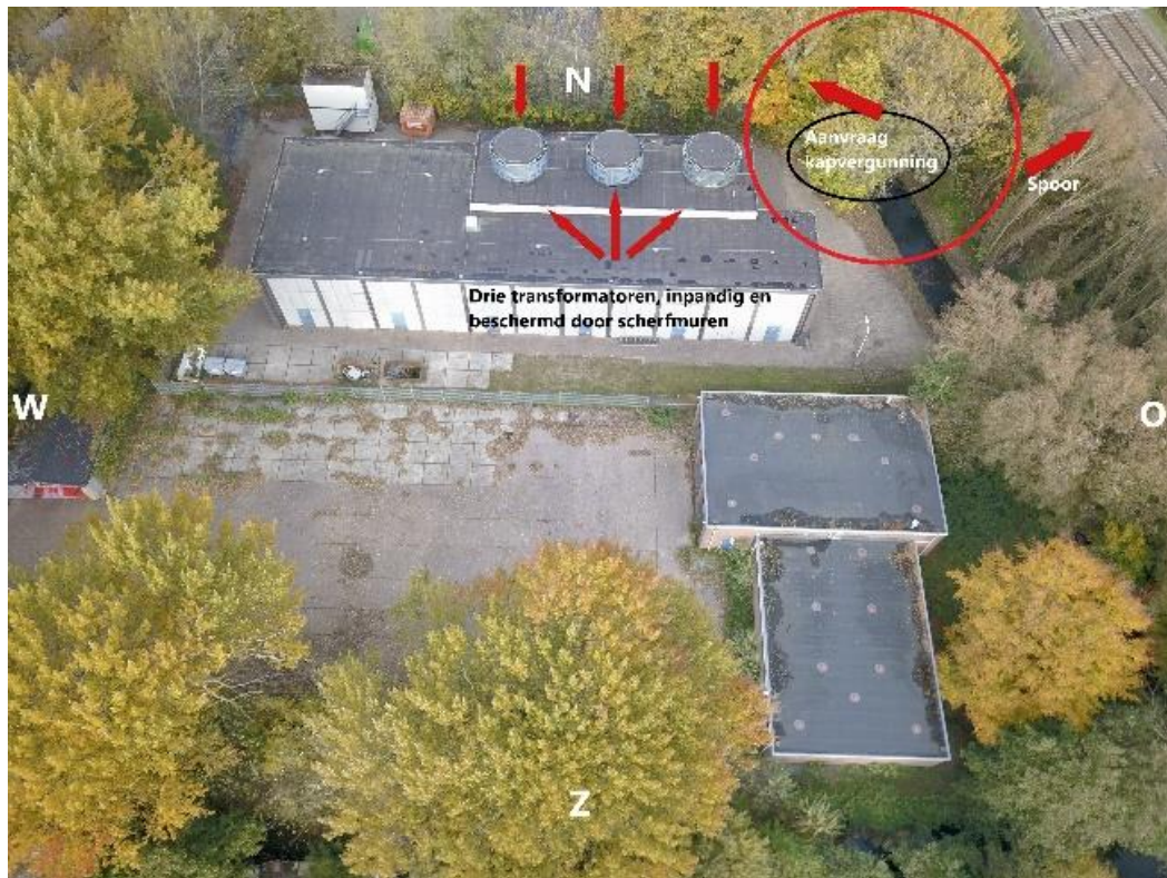
2. Het transformatorstation vanaf het zuiden. Rechts achterin (aangegeven met cirkel) de bomen. Ook een stukje van het spoor is zichtbaar.
